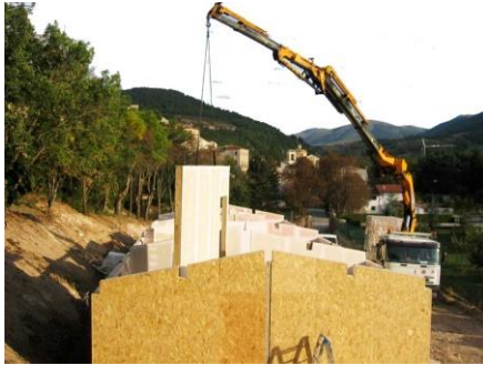
M.A.P. (moduli abitativi provvisori) Dipartimento di protezione civile
